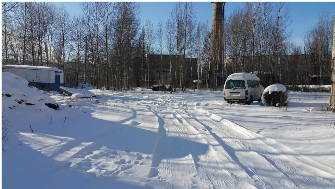
Незадействованные площади: часть нежилого здания бани, год постройки 1986г.
